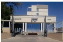
"Orley" Hotel Модернизация центрального оборудования пожарной сигнализации
